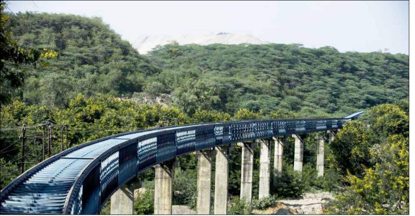
चित्र: एनसीएल की कृष्णशिला ओसी: बेल्ट पाइप कन्वेयर
