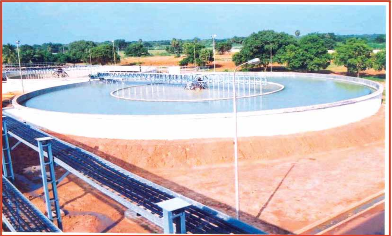
चित्र: वडाकुथु (वीरानम) में 180 एमएलडी वाला शोधन संयंत्र
