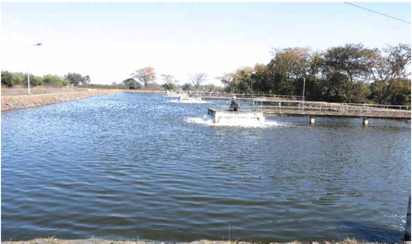
Fig. ETP at Gevra OCP, SECL
