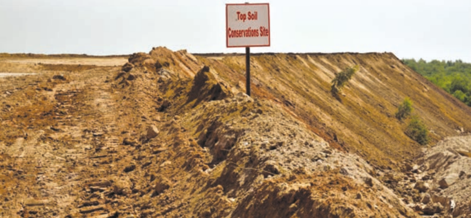
नॉर्दन कोलफील्ड्स लिमिटेड के मध्य प्रदेश स्थित निगाही क्षेत्र में अधिभार डंप पर मिट्टी की ऊपरी परत के संरक्षण का कार्य
